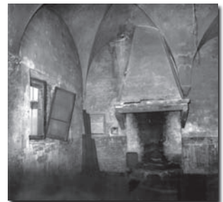
Interno del Torresotto prima della ristrutturazione 1° piano
